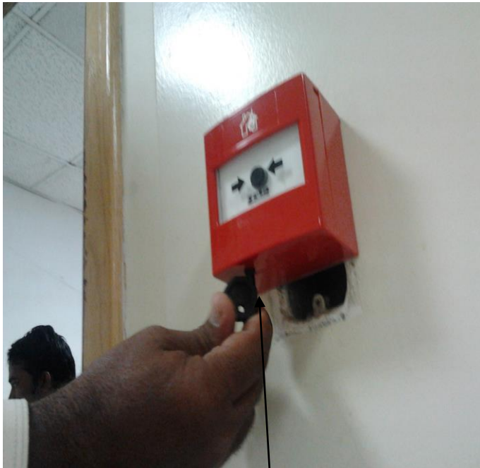
يتم ارجاع الكاسر الى الحالة الطبيعية عن طريق استخدام المفتاح الخاص به من خلال فتحة موجودة اسفل الكاسر الزجاجى
