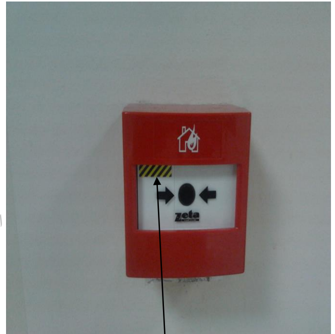
الكاسر الزجاجى بعد الضغط عليه وتظهر علامة مخططة باللون الاصفر والاسود تدل على انه قد تم الضغط على هذا الكاسر
